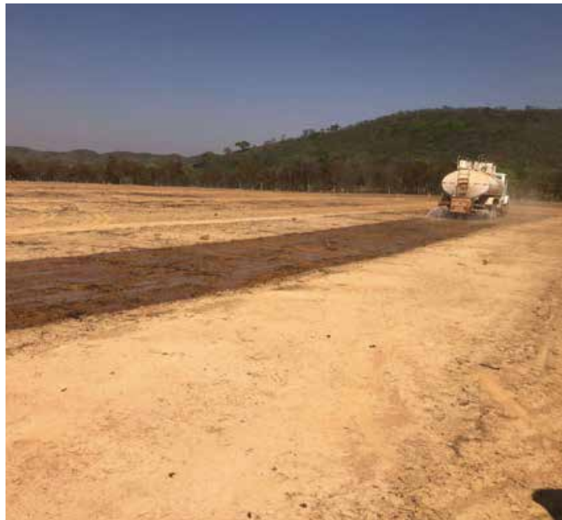
Figura 2: linha de medição em solo árido umedecida com caminhão tanque.
