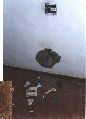
Foto 14 A descarga atingiu a palmeira da direita, gerou um surto induzido na rede elétrica da casa localizada a aprox. 20 metros. A instalação elétrica ainda não tinha sido inaugurada. Verificar o dano mecânico no meio fio próximo da árvore. Local: Nova Lima - MG
