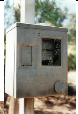
Foto 10 O raio entrou pelo telhado, desceu pela fiação do interruptor e derrubou a parede para chegar no solo. Derreteu toda a fiação e tubulação de PVC, destruiu o padrão de energia e o transformador, logo acima deste. Local: Moeda - MG
